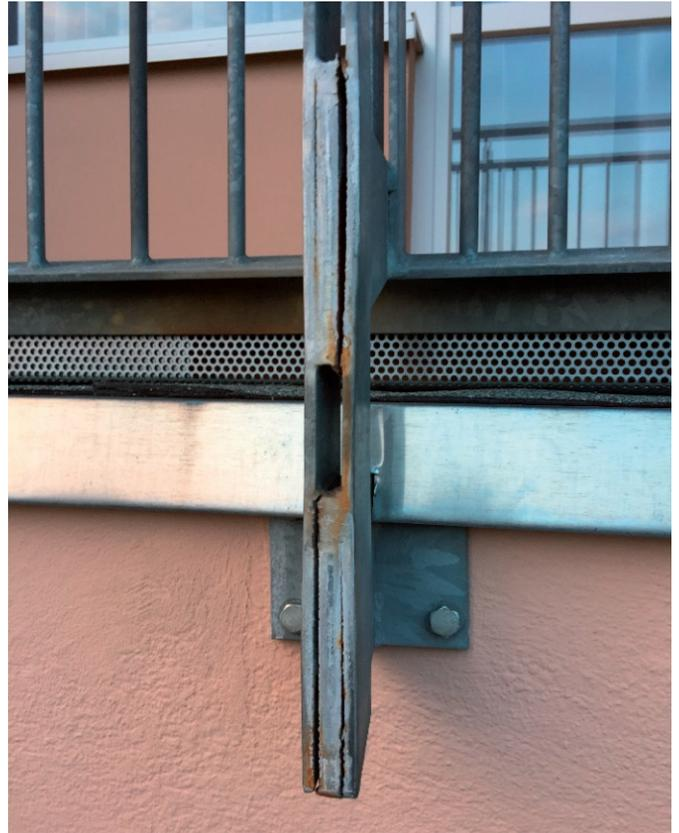
Schaden an einem feuerverzinkten Geländerpfosten mit nur teilweise verschweissten Überlappungen
